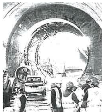
Il Terzo Valico, cantiere Pnrr
